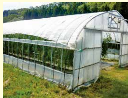
写真1 側窓、妻面、肩換気
