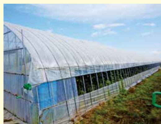
写真2 塗布剤散布後のハウス
